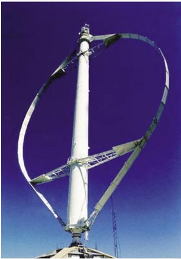
Aerogenerador con rotor Darrieus
