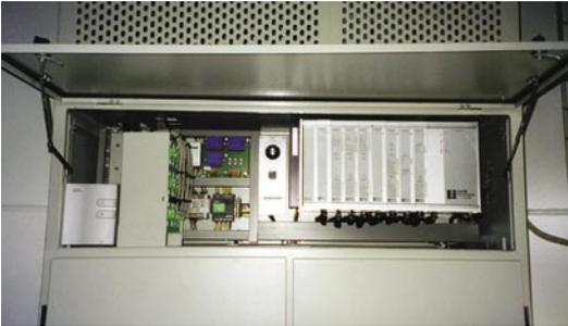
Sistema de control de un aerogenerador
