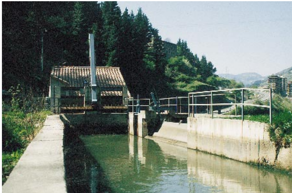
Foto 8. Cámara de carga y edificio C.H. Sologoen (Cortesía de C.H. Sologoen, S.A.)
