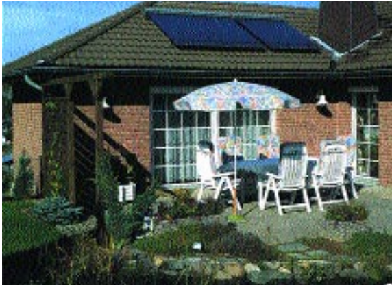
■ Instalación Solar doméstica con Colector de tubo de vacío. Cortesía de Viessmann
