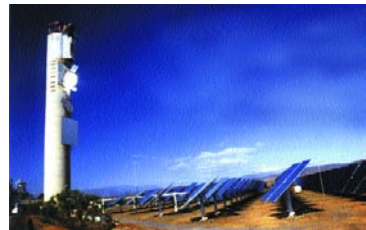
Campo de heliostatos y torre de la Plataforma. Planta Solar de Almería.
