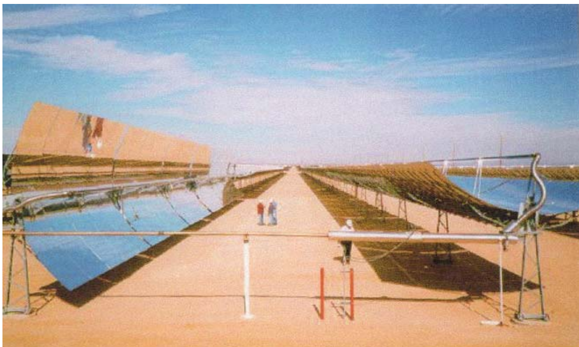
Figura 1. Instalación de colectores Cilindroparabólicos
