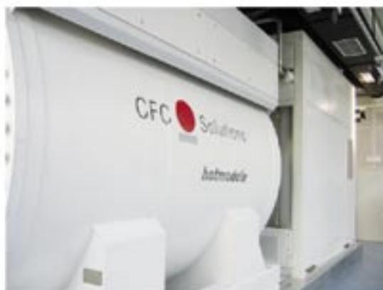
Fig.4. Pila de combustible de carbonatos fundidos, de 200 kW en la sede de Gas Natural.
