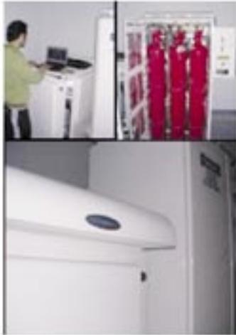
Fig.6. Instalación de pila de combustible de 5 Kw. de Plug Power como back-up para un sistema de comunicación por radio con los barcos.
